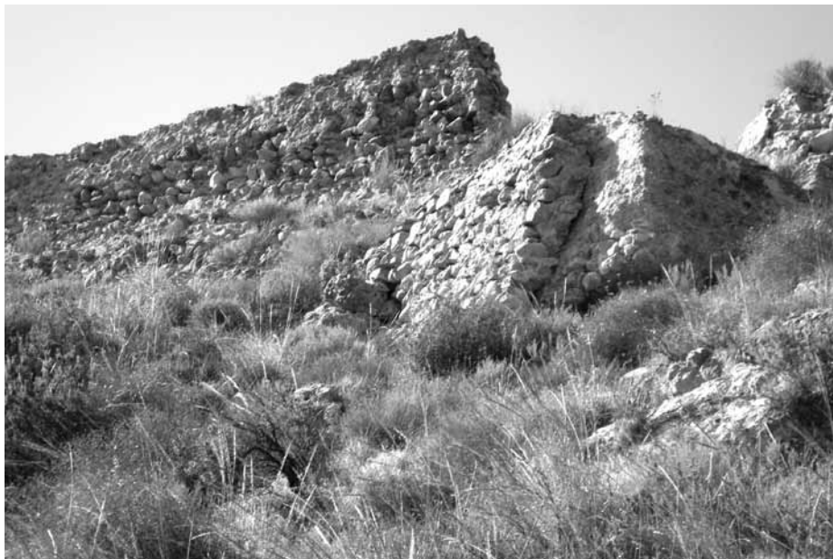
Lámina 14. Castillo de Calentín. Recreido de mampostería en muro de tapial de calicanto.
