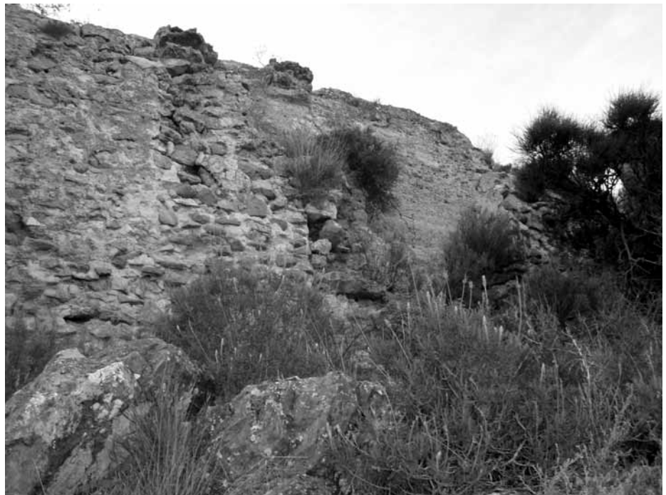
Lámina 11. Castillo de Ugéjar. Muralla zona intermedia. Tramos de mampostería y de tapial hormigonado.
