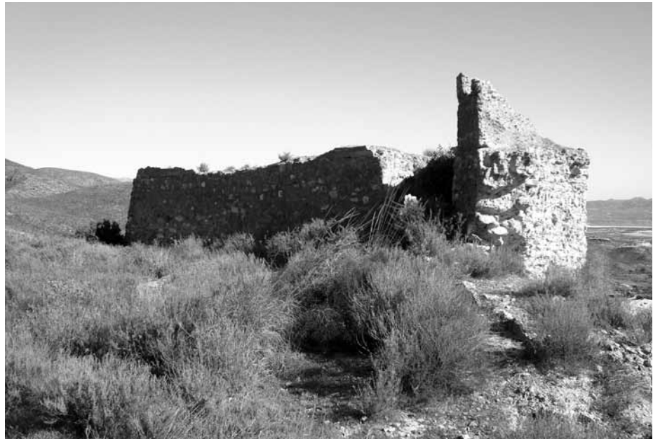
Lámina 13. Castillo de Calentín. Muralla y torre, cara N. Nivel inferior de mampostería y nivel superior de tapial.
