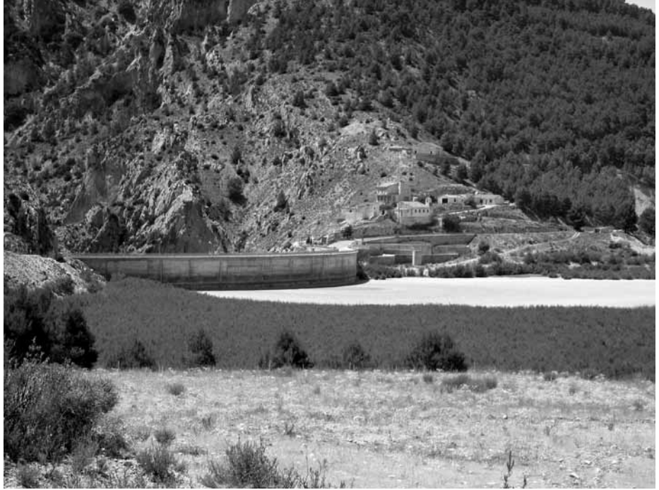
Lámina 11. Vista del vaso del embalse totalmente vacío en el verano de 2005.
