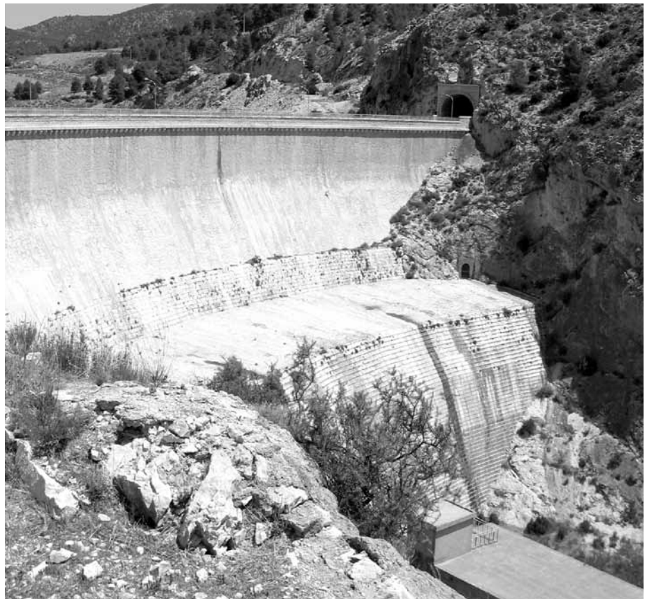
Lámina 3. Presa de Valdeinfierno, donde se observan sus recrecimientos.
