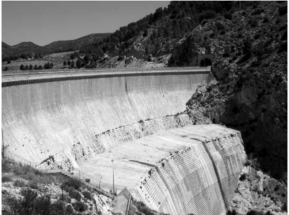
Lámina 12. Presa de Valdeinfierno.
