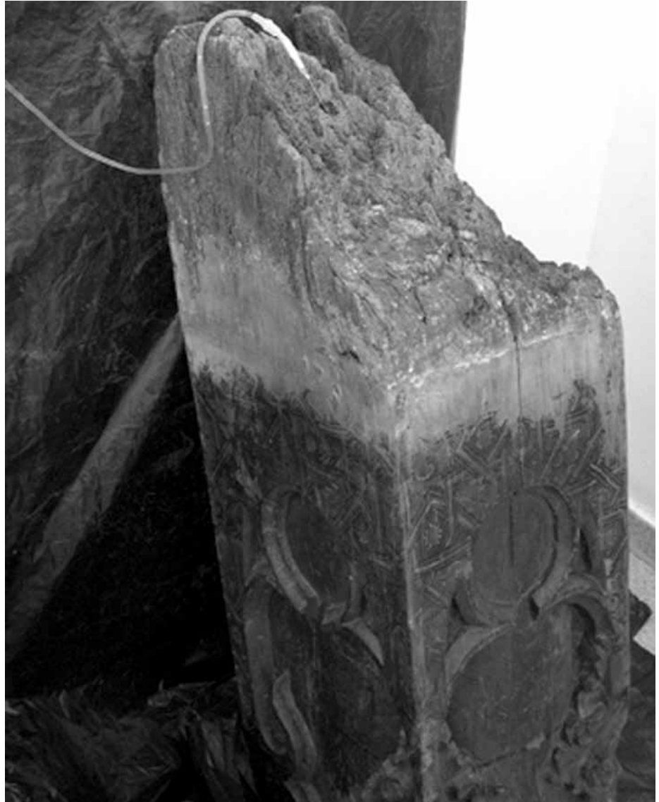
Lámina 8. Consolidación de la madera por impregnación con goteos.
