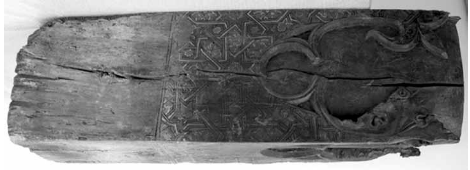
Lámina 1. Vista general de la ménsula 2251 antes de los tratamientos de restauración.
