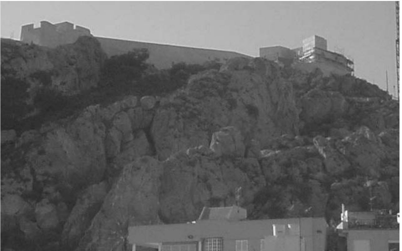
Lámina 4. Vista General de la Fortificación. Actualmente en fase de restauración.
