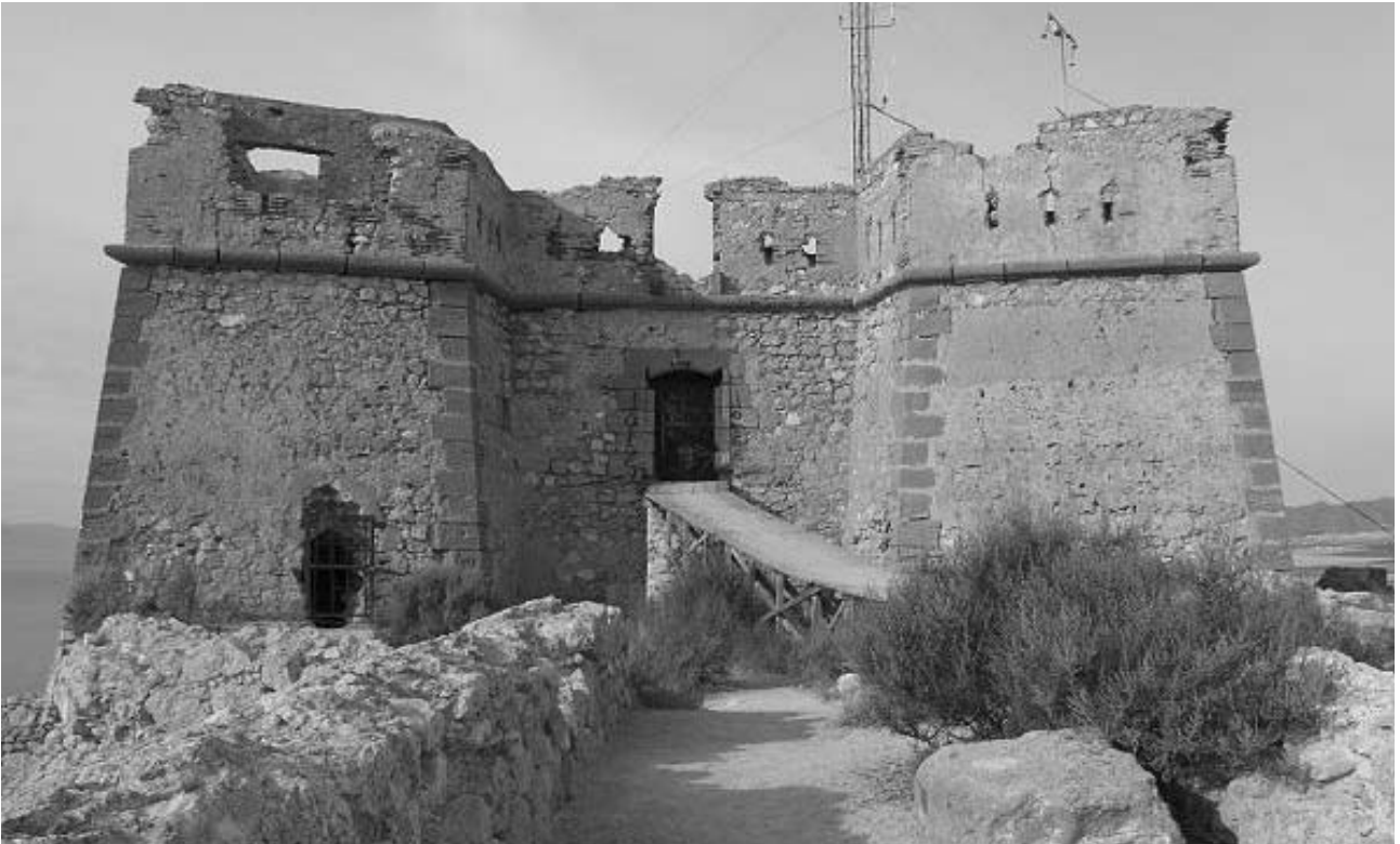
Lámina 3. Estado del Fuerte de San Juan previo a la restauración
