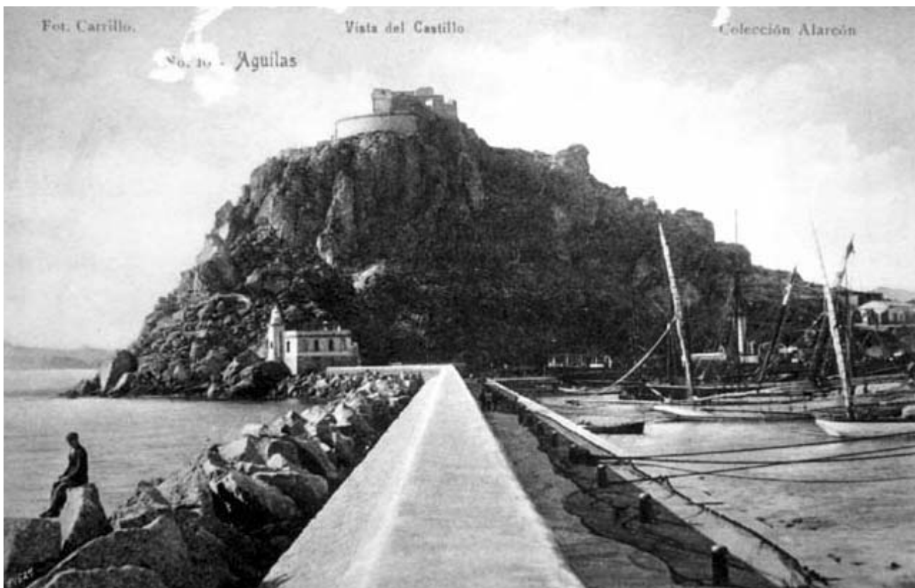
Lámina 2. Estado del Castillo en 1880. Se observa la obra que mantiene el enlucido original.
