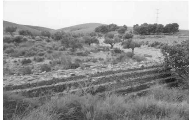
Lámina 9. Estribo de la margen derecha de la presa de Hinojar.
