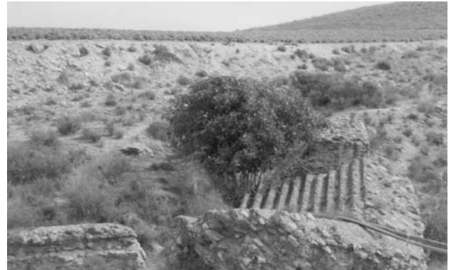
Lámina 7. Vista general de la presa de Hinojar.
