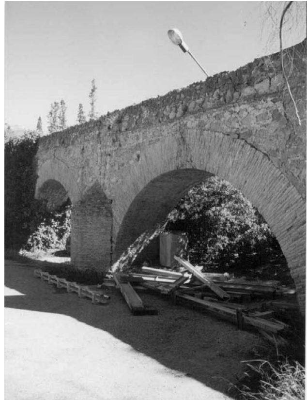
Lámina 3. Detalle del acueducto con arcos y ladrillo en rosca y tajamar.
