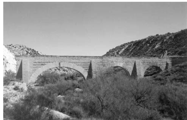
Lámina 4. Vista de un tramo de tres arcos del Acueducto de la Zarzadilla.
