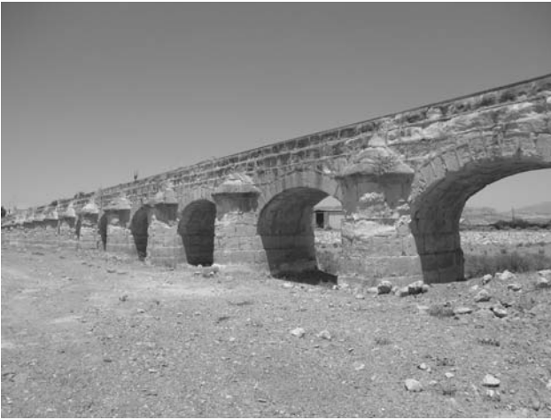
Lámina 1. Vista general del Acueducto de los Diecisiete Arcos.
