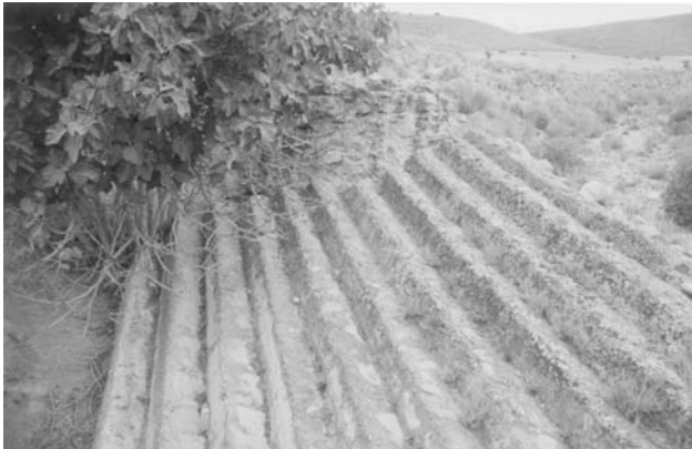
Lámina 8. Detalle de los escalones en el paramento de aguas abajo de la presa.
