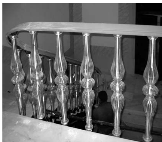
Lámina 13. Detalle de las balustradas.
