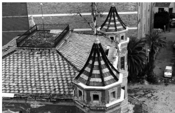
Lámina 6. Vista estado primitivo.
