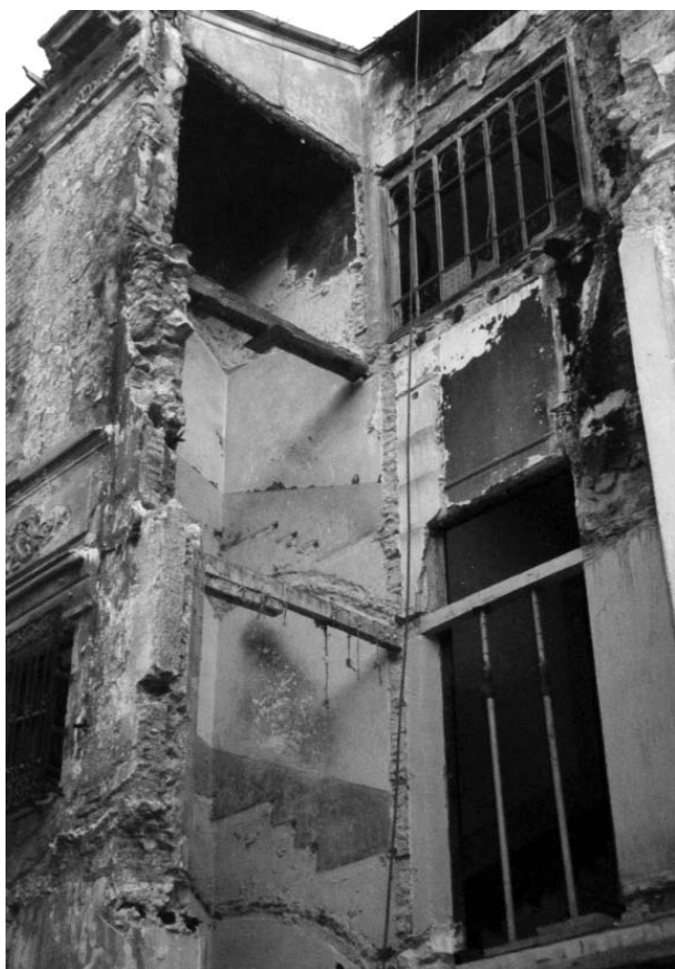
Lámina 8. Vista estado primitivo.
