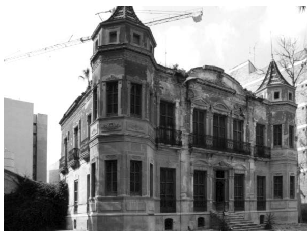
Lámina 7. Vista estado primitivo.
