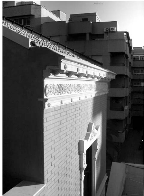
Lámina 21. Detalle de la parte superior del edificio.
