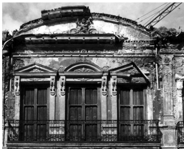
Lámina 5. Vista estado primitivo.
