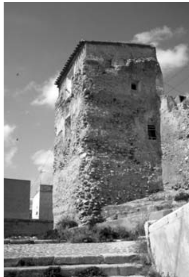
Lámina 11. Torreón de la calle Ramírez junto al Pósito de los Panaderos (Archivo fotográfico de Andrés Martínez Rodríguez).
