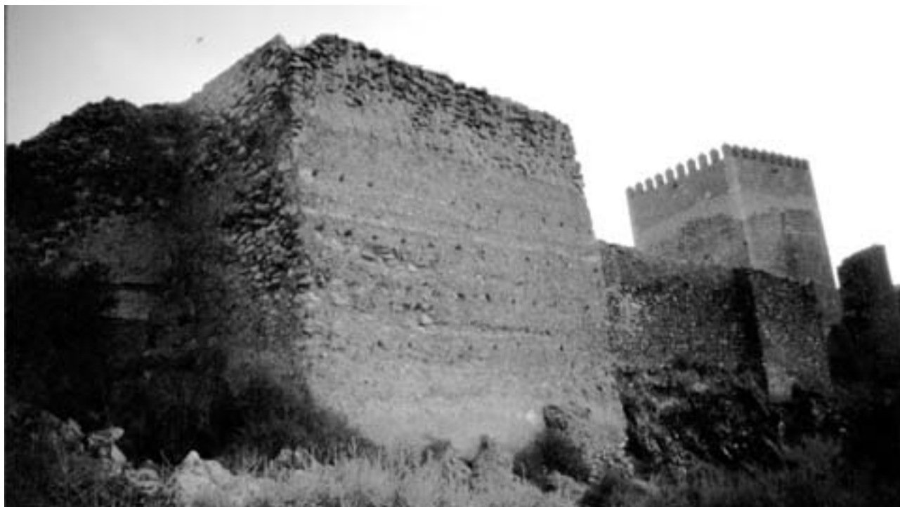
Lámina 2. Torre rectangular de la muralla de tapial de la alcazaba de Lorca (Archivo fotográfico de Andrés Martínez Rodríguez).
