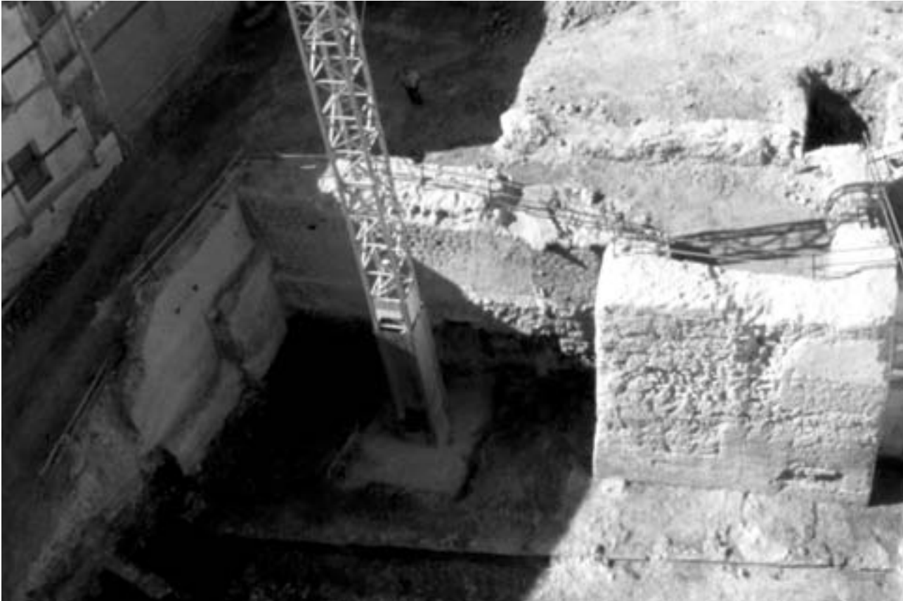
Lámina 7. Torreón islámico de tapial que une con un lienzo de mampostería cristiana en el Convento de las Madres Mercedarias (Archivo fotográfico de Ana Pujante Martínez).
