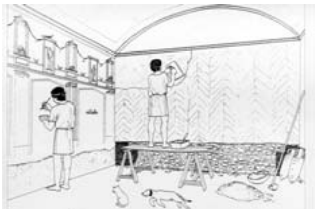
Figura 1. Distintas etapas de la preparación y del acabado de una pared al fresco (ADAM, 1996: 242).
