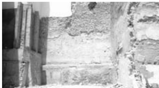
Lámina 2. Torreón noroeste y lienzo de muralla.
