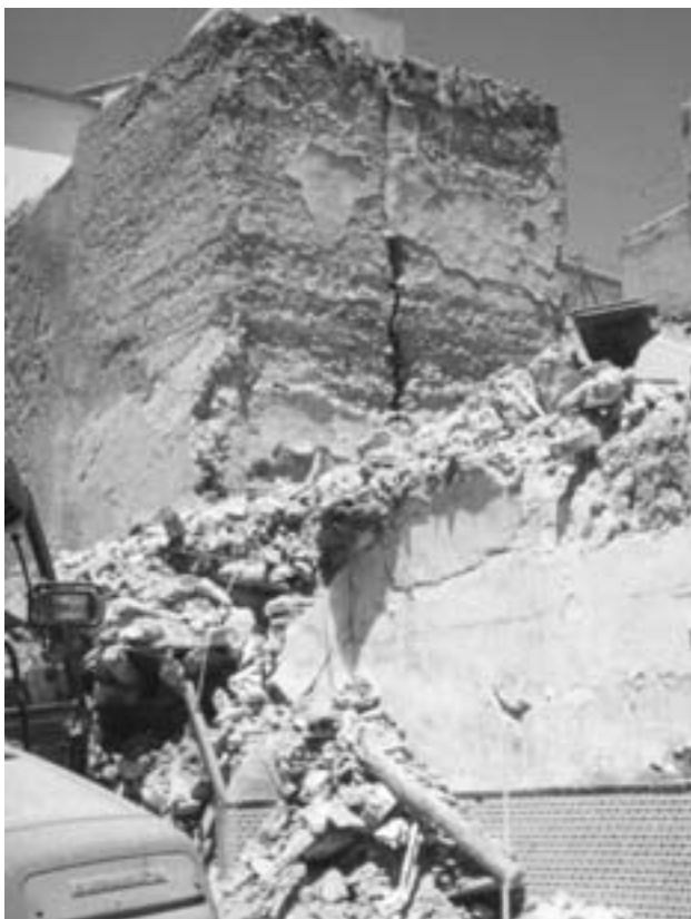
Lámina 1. Proceso de derribo.
