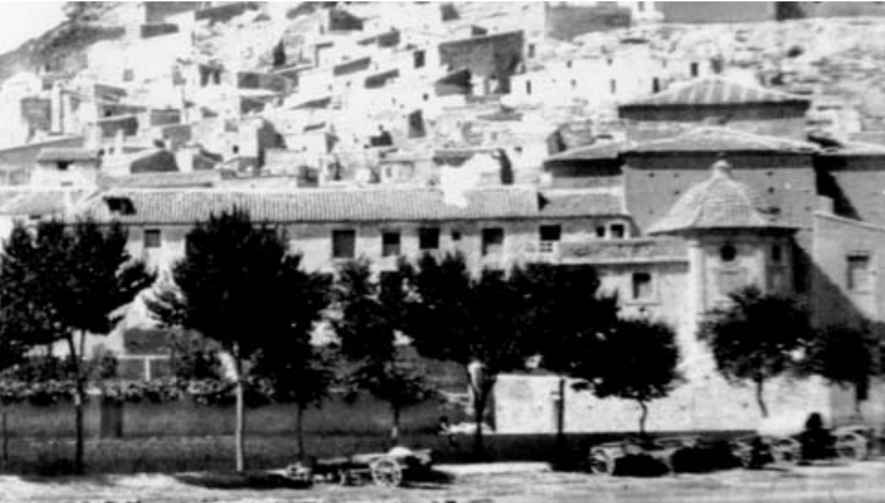
Lámina 5. Vista de la fachada Este de la iglesia, donde se aprecia el primer plano el Camarín de la Virgen de la Soledad (A.M.L.).
