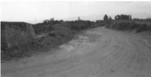
Lámina 10. Aliviadero y conducción (sector 3).
