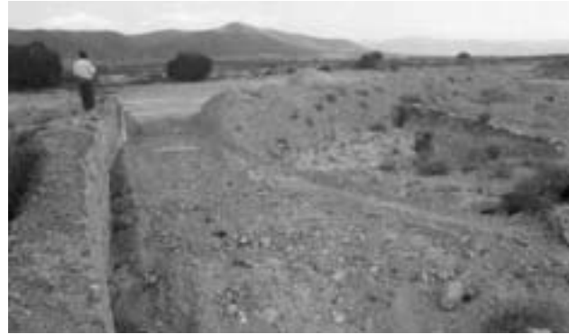
Lámina 21. Muro que sirve para desviar el agua hacia la boquera (sector 3).
