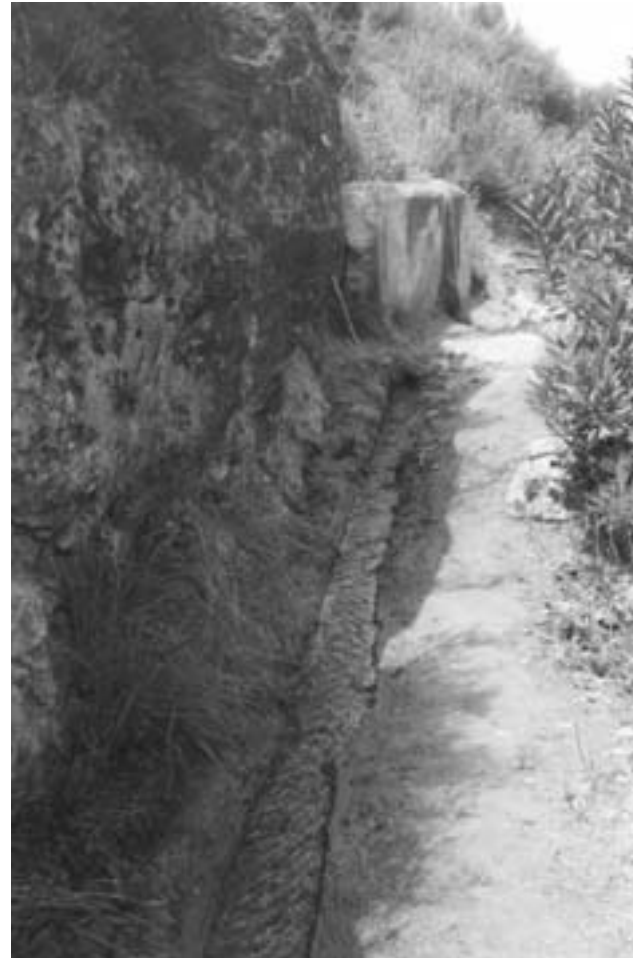
Lámina 11. Conducción que lleva a la balsa.
