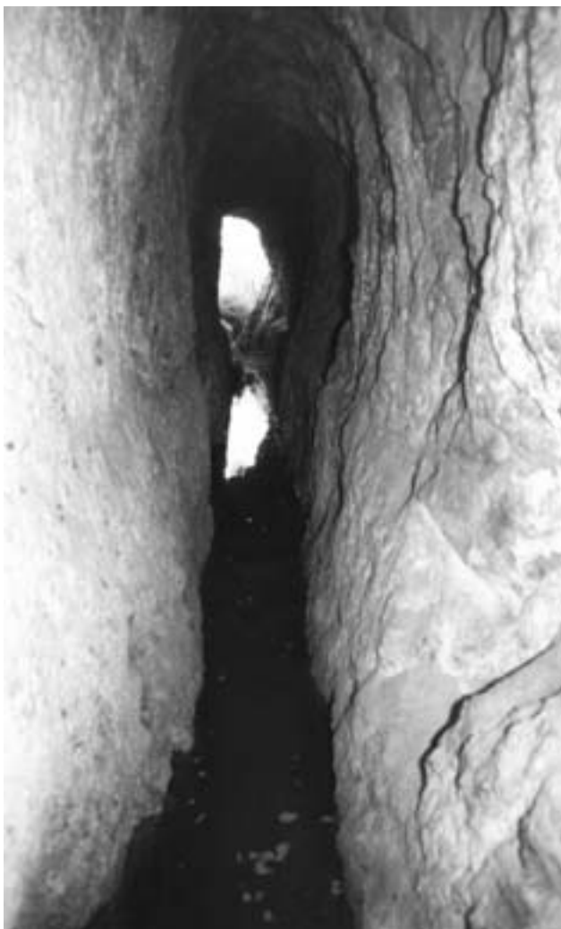
Lámina 22. Detalle de la galería (sector 1, toma 2).
