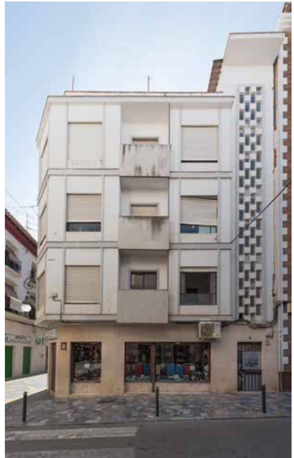
Lámina 4. E. Sancho Ruano. Edificio en calle Álamo 26. (Fotografía: © Fernando M. García Martín)
