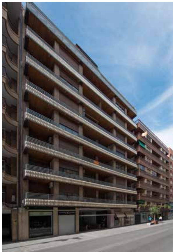
Lámina 8. E. Sancho Ruano. Edificio Avenida . (Fotografía: © Fernando M. García Martín)
