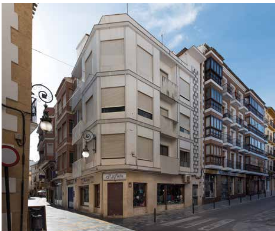
Lámina 3. E. Sancho Ruano. Edificio en calle Álamo 26. (Fotografía: © Fernando M. García Martín)
