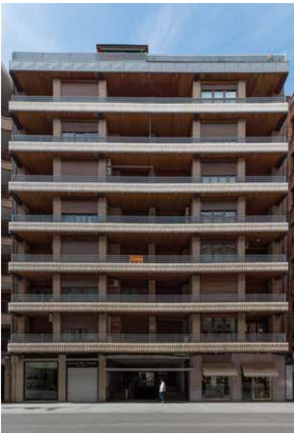
Lámina 7. E. Sancho Ruano. Edificio Avenida . (Fotografía: © Fernando M. García Martín)
