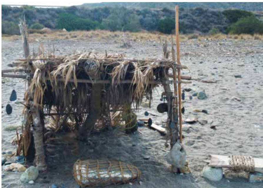
Lámina 13. «Candalacho» de pescadores construido con troncos, ramas y cañas trabadas con cordelería. Penden de la estructura numerosas pesas líticas de tamaño variado, playa de El Algarrobico (Carboneras, Almería). (Fotografía: Autor 29-VIII-2019)
