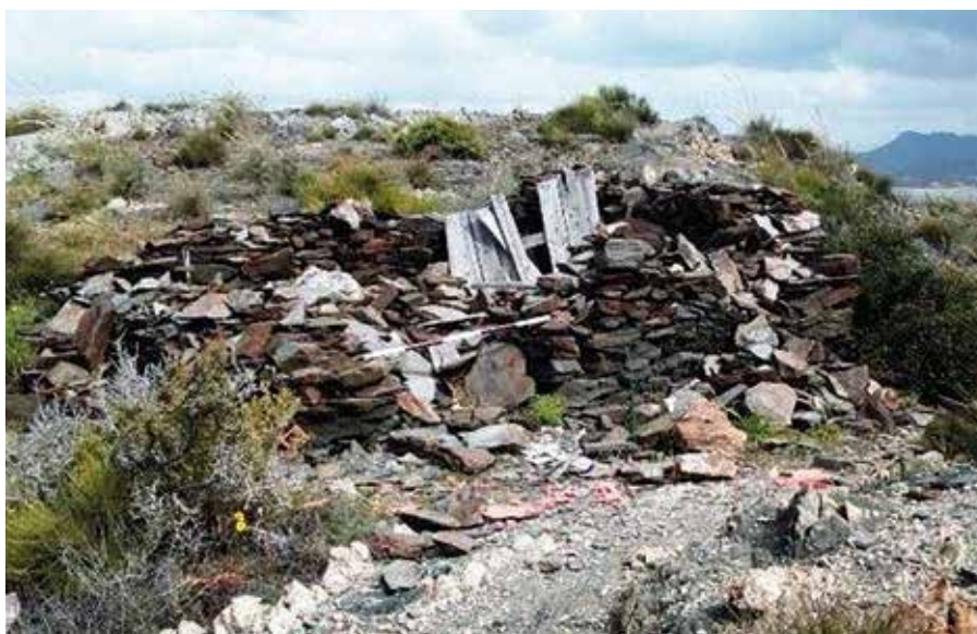
Lámina 4. Apostadero 1, realizado en piedra seca usando lajas de esquistos del lugar (19-IV-2017). (Fotografía: Autor, (19-IV-2017))
