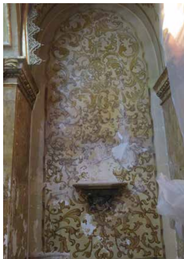
Lámina 3. Detalles del estado inicial de las pinturas parietales.
