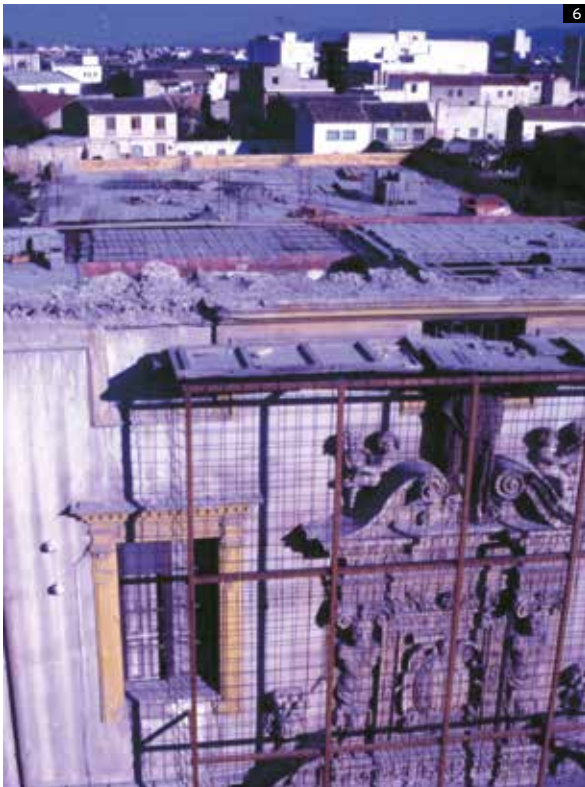
Lámina 6. Detalle del hormigonado de cubierta. (Fotografía: Archivo del autor)
