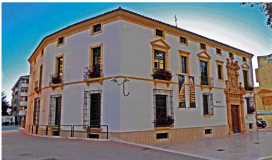
Lámina 14. Aspecto de la fachada principal y lateral izquierda del Museo Arqueológico. Fecha: 16/01/2020. (Fotografía: Archivo del autor)
