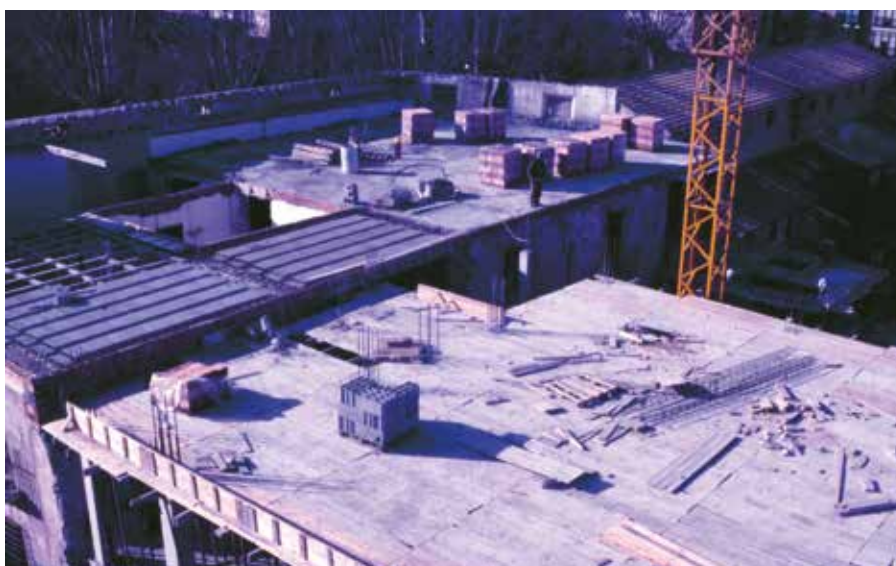
Lámina 9. Detalle del penúltimo forjado antes del hormigonado. Marzo de 1987. (Fotografía: Archivo del autor)
