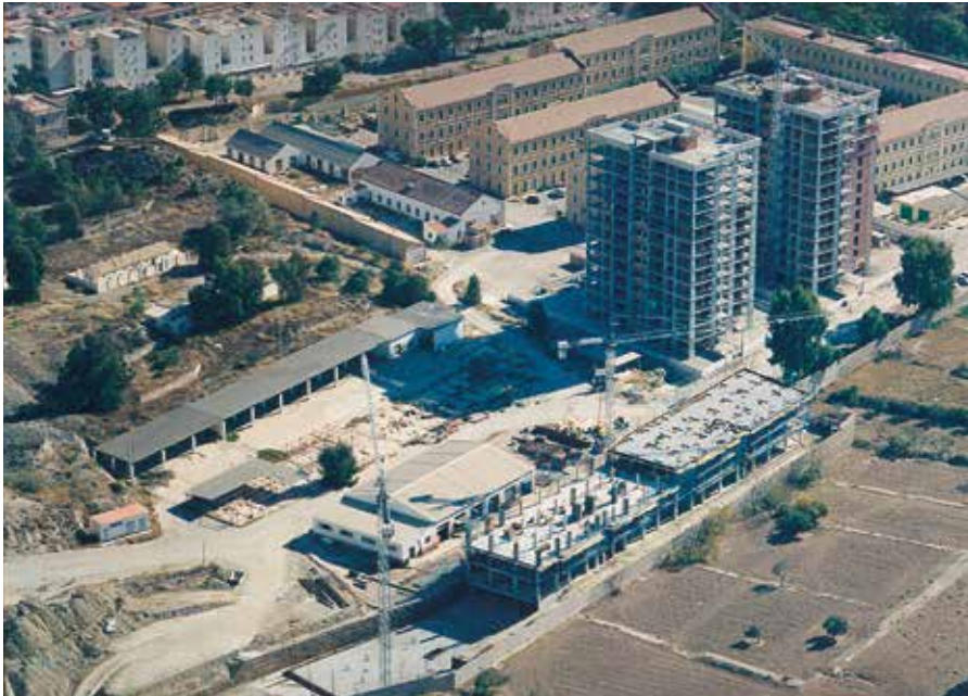
Lámina 3. Las dos torres más altas destinadas a viviendas están recién terminadas –la estructura– y delante se trabaja en la estructura de otros bloques. Al fondo se pueden ver todavía los pabellones originales.
