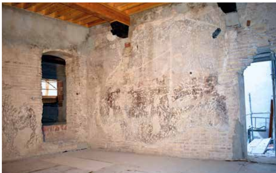
Lámina 2. Muros oeste y norte de la sala donde se hallan los grafitos.
