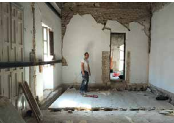
Lámina 15. Izquierda: Sala este en planta primera al inicio de los trabajos. Se aprecia la comunicación espuria con la otra vivienda, abierta probablemente durante el siglo xx. Los forjados absolutamente deteriorados se han reforzado mediante tableros contralaminados. Se han reparado la totalidad de los muros mediante inyecciones y cosidos con varillas de fibra de vidrio, así como la cubierta de madera. Derecha: La sala, una vez finalizadas las obras, con las vigas, canecillos, viguetas y revoltones completamente reparados, además de las carpinterías (todas las contraventanas son las antiguas).
