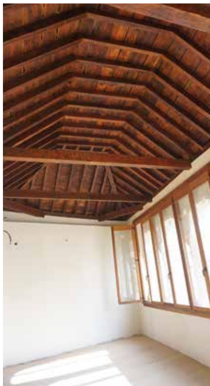
Lámina 11. Armadura de cubierta del mirador, restaurada.
