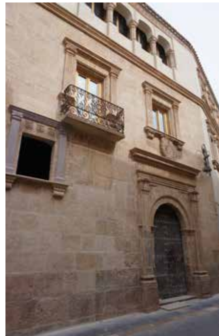
Lámina 20. Estado previo (izda.) y final (dcha.) de la fachada y portada principal. Las piezas de sillería faltantes se han reproducido, pero utilizando piedra de mayayo para diferenciarlas de las originales.
