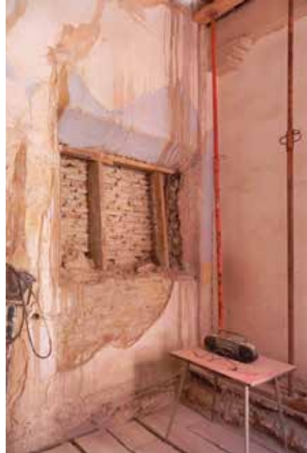
Lámina 13. Momento en el que se descubrió la puerta tabicada que comunicaba la escalera y la vivienda este de planta primera.
