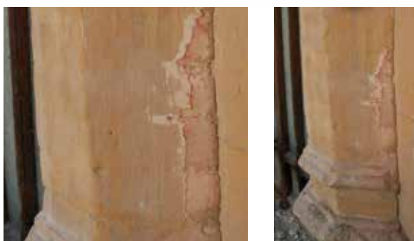
Figura 5. Arriba: Alzado principal con localización de las catas efectuadas. Debajo: Fotografías de la ficha correspondiente a la cata marcada con un punto rojo, en la que se aprecia una capa exterior de pintura plástica beige con base blanca y por debajo, un temple de color almagra aplicado sobre una fábrica de ladrillo (se repite a lo largo de todo el fuste).
