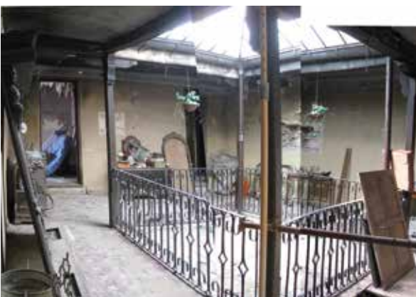
Lámina 16. Izquierda: Espacio central de la planta segunda al inicio de las obras, con los forjados en ruina, deterioros enormes en la cubierta, huecos espurios, puertas tabicadas, etc. Derecha: La misma sala una vez ejecutado el nuevo alfarje de madera y recuperados los niveles, huecos de paso, etc.
