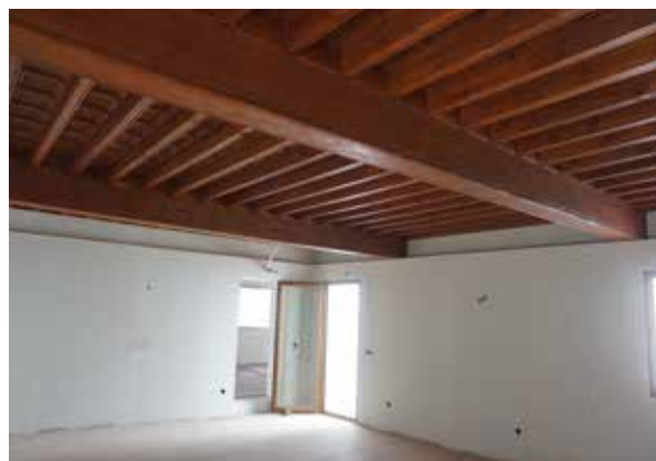
Lámina 16. Izquierda: Espacio central de la planta segunda al inicio de las obras, con los forjados en ruina, deterioros enormes en la cubierta, huecos espurios, puertas tabicadas, etc. Derecha: La misma sala una vez ejecutado el nuevo alfarje de madera y recuperados los niveles, huecos de paso, etc.
