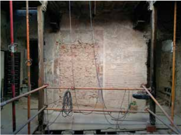
Lámina 14. Izquierda: El patio central en su lateral sur de la planta primera al inicio de las obras, en el momento en el que se descubrió una hermosa puerta tabicada y multitud de grafitis en sus jambas. Derecha: El mismo espacio, tras las obras, eliminados los pies derechos y recuperadas las grandes vigas y sus canes, así como la totalidad del alfarje. La puerta original vuelve a su estado primitivo, permitiendo la comunicación entre las dos estancias principales de esta planta (en la imagen todavía no se ha finalizado su consolidación).
