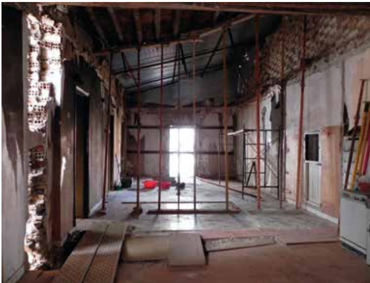
Lámina 18. Salón oeste de la planta segunda. Izquierda: Al inicio de los trabajos, con parte de las cubiertas derruidas, enormes grietas en los muros, forjados deteriorados, etc. Derecha: La sala una vez recuperados todos sus niveles de forjado y de cubierta. Esta última tiene una nueva estructura de pares, apoyados sobre durmientes, con cuadrales en las esquinas abiertas. Por encima, paneles sándwich con acabado inferior en yeso, de forma que presenta también despieces en sentido perpendicular a los pares, evitando los paños enteros (que no se corresponden con este tipo de armaduras tradicionales).
