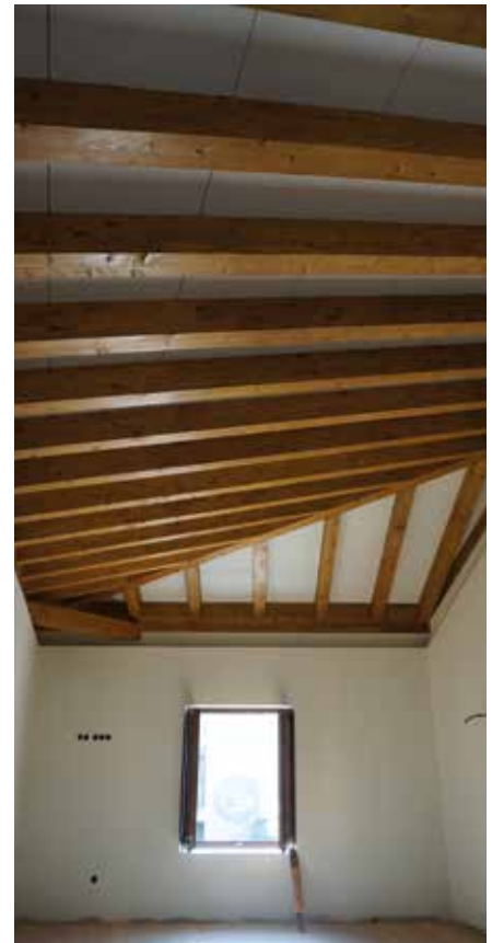
Lámina 17. A la izquierda, estado al inicio de las obras. A la derecha, a la conclusión de las mismas y realizados los trabajos de consolidación de la sillería pétreo, restauración del forjado de madera, solados, yesos, etc.
