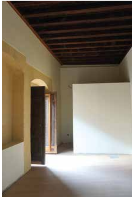
Lámina 17. A la izquierda, estado al inicio de las obras. A la derecha, a la conclusión de las mismas y realizados los trabajos de consolidación de la sillería pétreo, restauración del forjado de madera, solados, yesos, etc.
