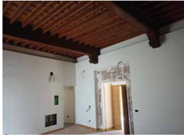
Lámina 14. Izquierda: El patio central en su lateral sur de la planta primera al inicio de las obras, en el momento en el que se descubrió una hermosa puerta tabicada y multitud de grafitis en sus jambas. Derecha: El mismo espacio, tras las obras, eliminados los pies derechos y recuperadas las grandes vigas y sus canes, así como la totalidad del alfarje. La puerta original vuelve a su estado primitivo, permitiendo la comunicación entre las dos estancias principales de esta planta (en la imagen todavía no se ha finalizado su consolidación).
