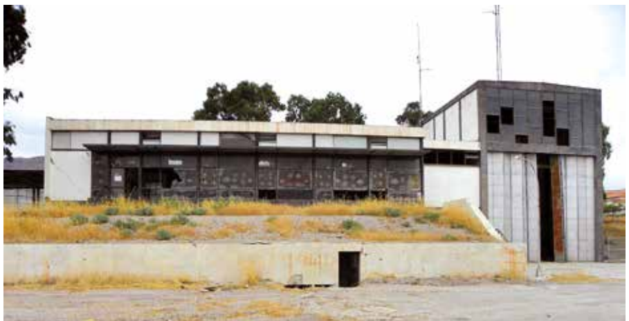
Lámina 5. Subestación eléctrica de Lorca. Vista frontal. Fotografía de J. Granados (agosto de 2017).
