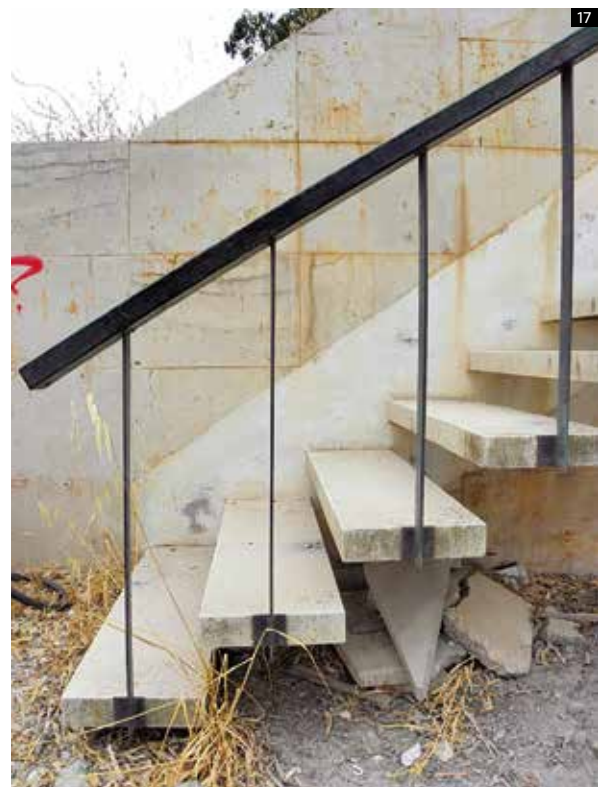
Lámina 16. Subestación eléctrica de Lorca. Escalera exterior. Fotografía de J. Granados (agosto de 2017).
