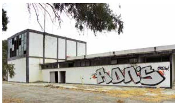
Lámina 12. Subestación eléctrica de Lorca. Vista posterior. Fotografía de J. Granados (agosto de 2017).
