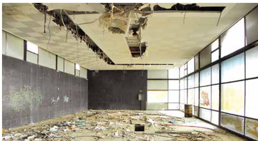
Lámina 14. Subestación eléctrica de Lorca. Interior sala de mandos. Fotografía de J. Granados (agosto de 2017).
