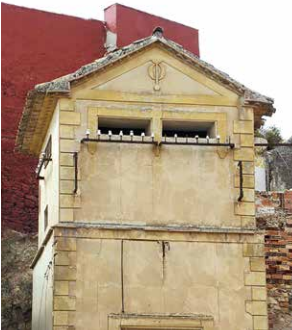
Lámina 2. Detalle de la fábrica de la luz de la calle Vicente Ruiz Llamas, Lorca. Fotografía de J. Granados (julio de 2014).
