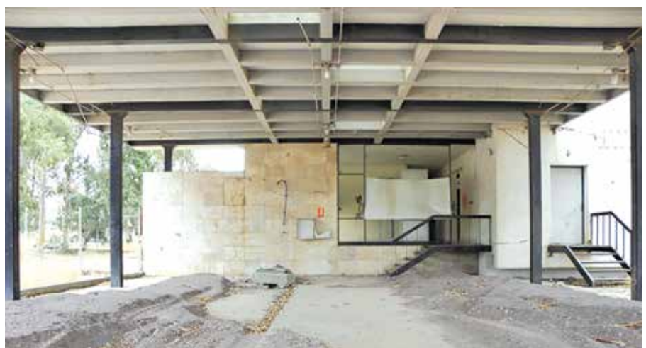
Lámina 9. Subestación eléctrica de Lorca. Celdas a la intemperie y acceso lateral. Fotografía de J. Granados (agosto de 2017).
