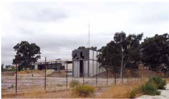
Lámina 1. Subestación eléctrica de Lorca. Vista general. Fotografía de J. Granados (agosto de 2017).
