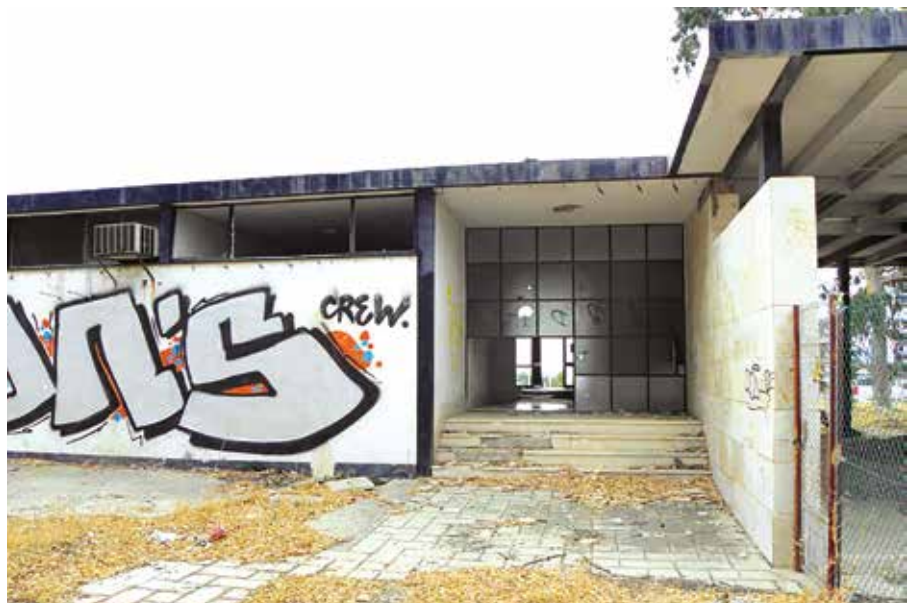
Lámina 8. Subestación eléctrica de Lorca. Acceso principal. Fotografía de J. Granados (agosto de 2017).
