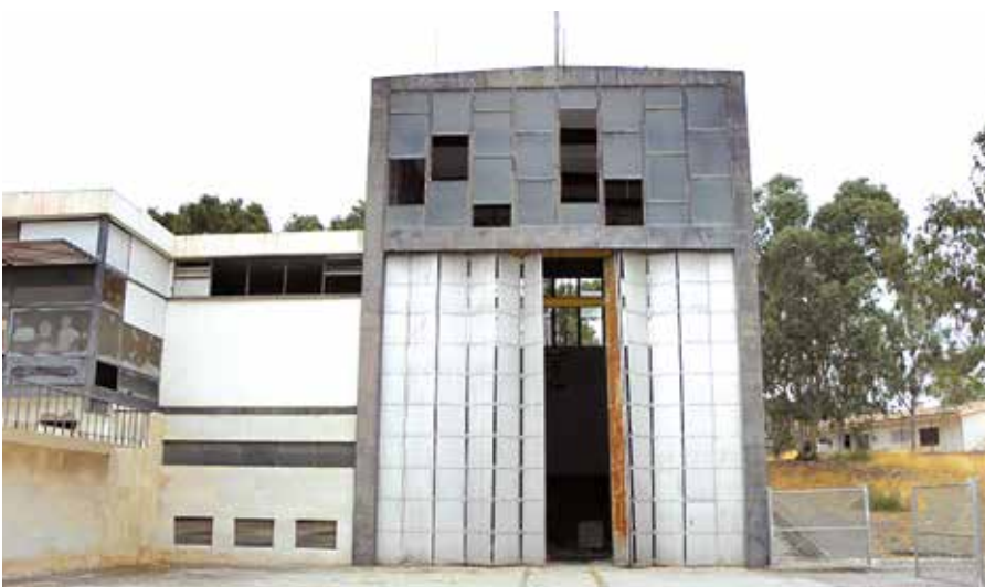
Lámina 7. Subestación eléctrica de Lorca. Torre de desencubado. Fotografía de J. Granados (agosto de 2017).
