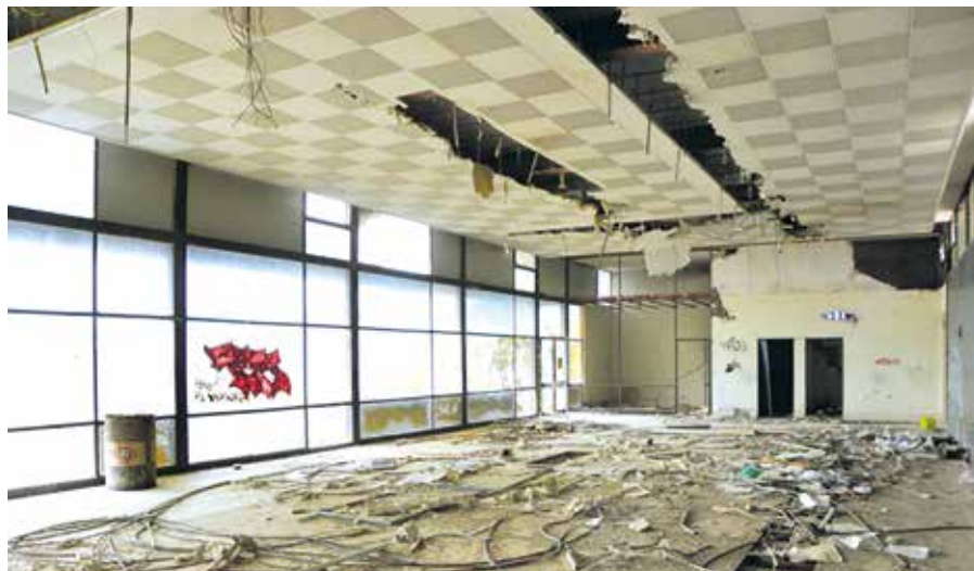
Lámina 13. Subestación eléctrica de Lorca. Interior sala de mandos. Fotografía de J. Granados (agosto de 2017).
