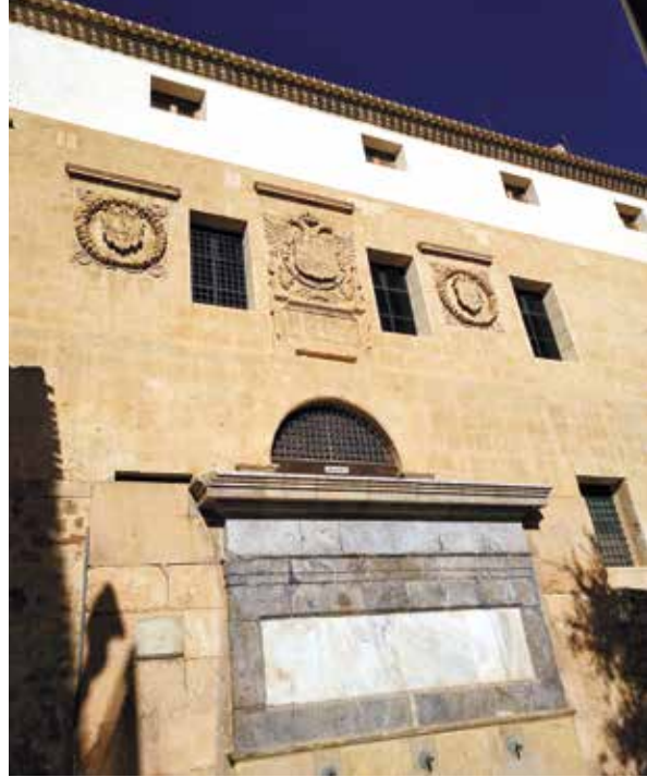
Lámina 16. Detalle de los escudos de la fachada principal del Pósito. Fotografía: Andrés Martínez.
