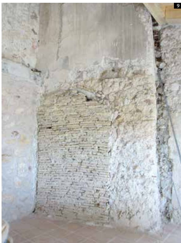
Lámina 9. Puerta abierta en el lateral occidental de la torre del Reloj, tapiada posteriormente con ladrillos. Fotografía: Ana Pujante.
