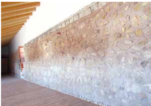
Lámina 11. Posible forro de mampostería situado en la segunda planta del Pósito. Fotografía: Ana Pujante.
