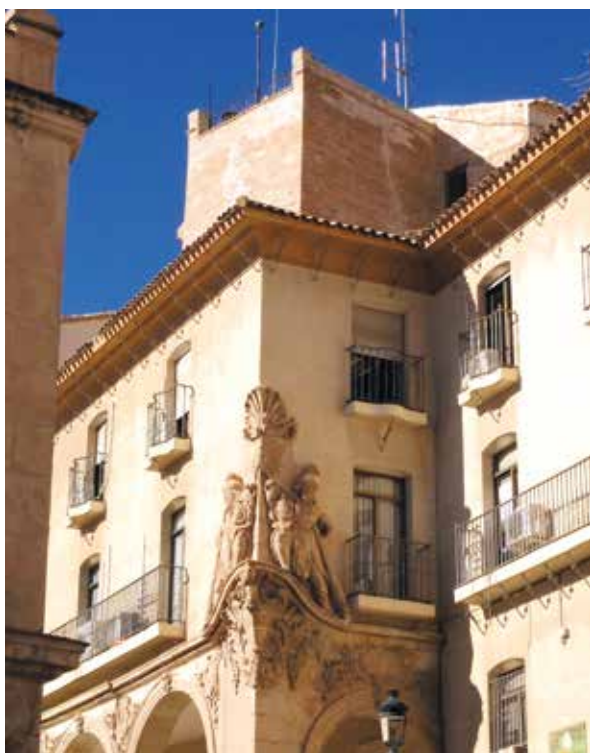
Lámina 1. Parte superior de la torre del Reloj construida en ladrillo. Fotografía: Andrés Martínez.
