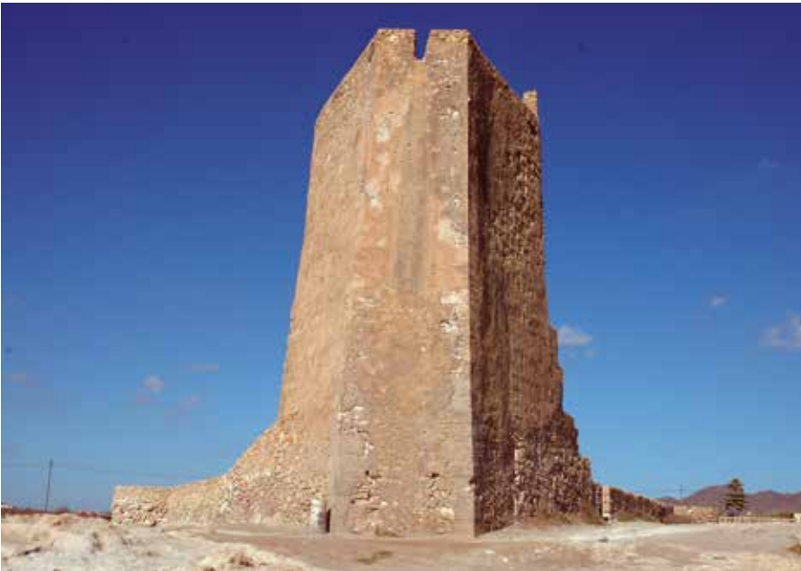
Lámina 2. Torre de Cope, desde el mar, Lorca.
