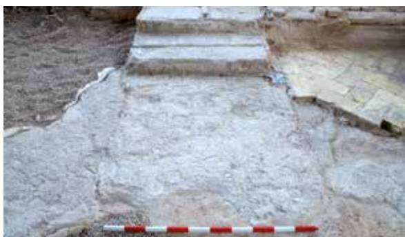
Lámina 13. Improntas de los azulejos sobre la argamasa de cal en el espacio entre el arón ha-qodesh y la bimá de la sinagoga de Lorca. Fotografía cedida por Patrimonio Inteligente.
