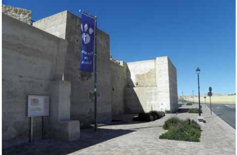
Lámina 6. Torre 5. Estado tras la intervención. Fotografía: J. Granados.
