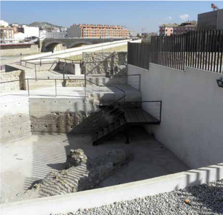
Lámina 9. Recuperación del nivel de adarve. Fotografía: J. Granados.
