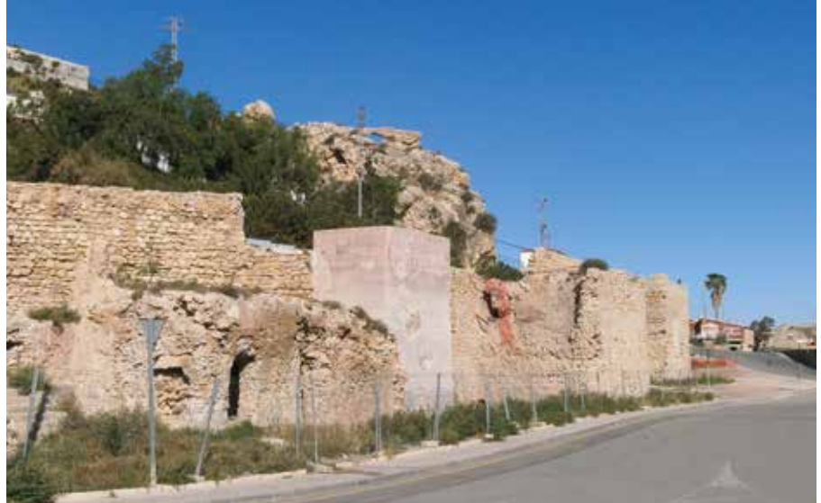
Lámina 1. Tramo de muralla de la calle Rambla. Estado anterior a la intervención. Fotografía: F. J. Fernández.
