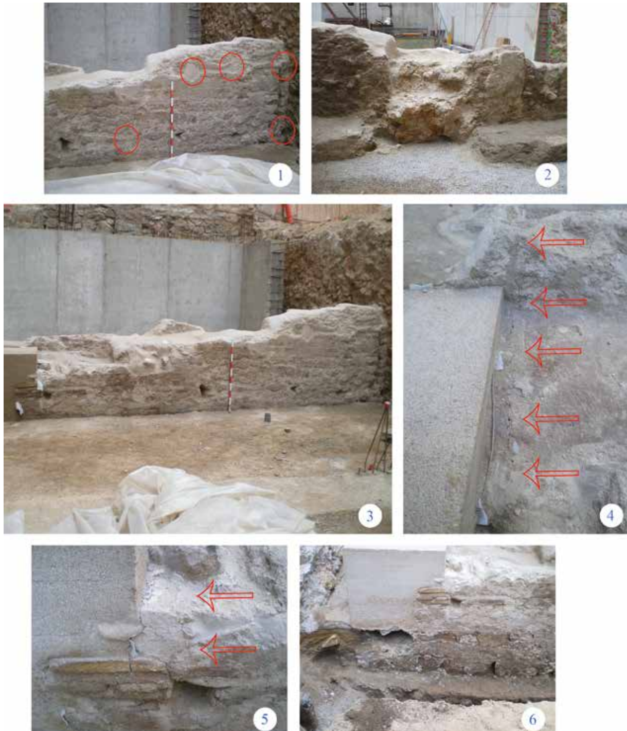
Figura 6. Composición donde se aprecian elementos que consideramos podrían haber variado si hubiese habido tal asesoramiento: 1. Sellado de los mechinales de una parte de la cara exterior de la muralla; 2. Detalle del interior en el que se ha protegido la coronación de la muralla, realizada en tierra, pero no de la cara interna, donde la mayor parte es también del interior de la muralla, ya que ha perdido la costra exterior; 3. Estado final de la cara externa de la muralla; 4. Agrietamiento producido en la muralla a raíz de la colocación de la estructura de la esquina; 5. Fotografía de detalle del agrietamiento de paños originales y de la reciente restauración debido al peso de la estructura colocada; 6. Vista de la esquina sur tras completar la excavación arqueológica de la cimentación, donde se ha recuperado el paño original y donde se ve que la realización de la restauración previamente a tener excavado todo el paño provocó ciertos agrietamientos en la muralla al no tener apoyo por la no conclusión de los trabajos arqueológicos.
