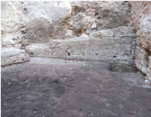
Lámina 4. Vista frontal del paño de muralla de tapial calicestrado.
