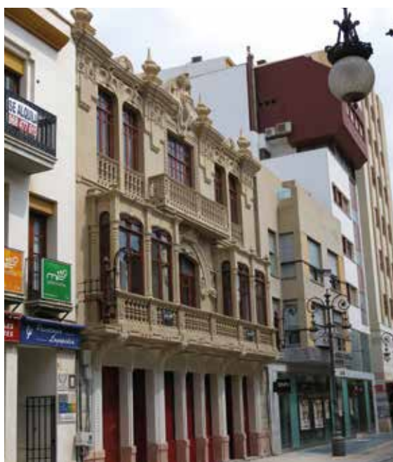
Lámina 7a. Fachada antes de la intervención de 2010.
