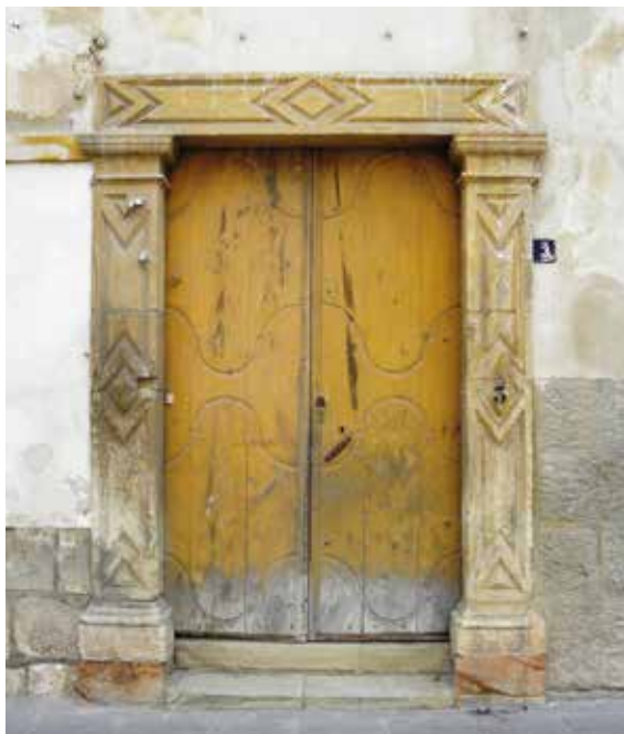
Lámina 8. Casa de los Quiñonero, Lorca. Fachada principal, portada. Fotografía: J. Granados, abril 2015.
