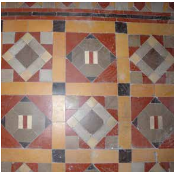
Lámina 40. Casa de los Quiñonero, Lorca. Dormitorio principal, suelo de mosaico de Nolla. Fotografía: J. Granados, junio 2015.
