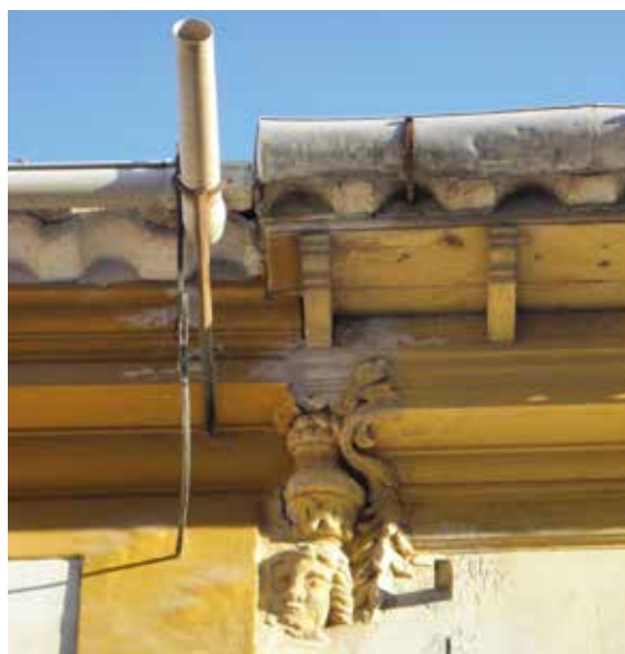
Lámina 7. Casa de los Quiñonero, Lorca. Fachada principal, extremo izquierdo de la cornisa. Fotografía: J. Granados, marzo 2014.
