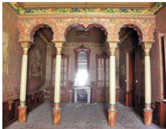
Lámina 29. Casa de los Quiñonero, Lorca. Comedor. Fotografía: J. Granados, diciembre 2013.
