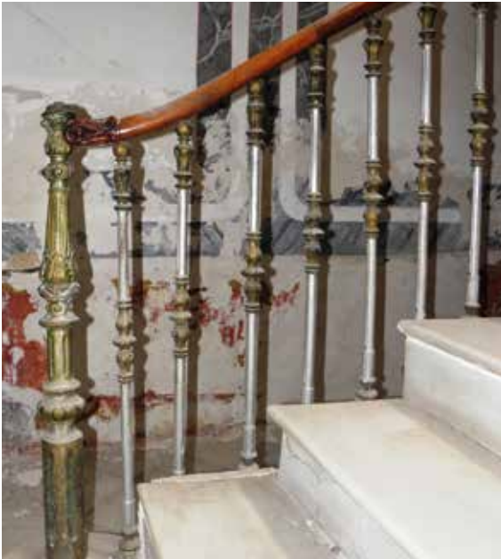
Lámina 11. Casa de los Quiñonero, Lorca. Escalera principal, barandilla. Fotografía: J. Granados, agosto 2015.
