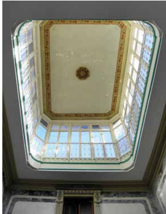
Lámina 18. Casa de los Quiñonero, Lorca. Torreón sobre la escalera principal, interior. Fotografía: J. Granados, marzo 2014.
