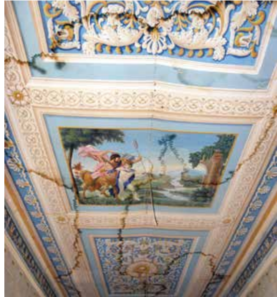
Lámina 23. Casa de los Quiñonero, Lorca. Salón de baile, lienzo del techo. Fotografía: J. Granados, marzo 2014.
