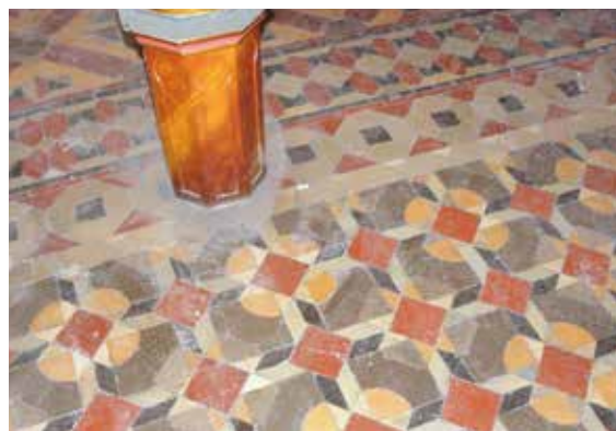
Lámina 31. Casa de los Quiñonero, Lorca. Comedor, suelo de la sala de fumar. Fotografía: J. Granados, abril 2015.
