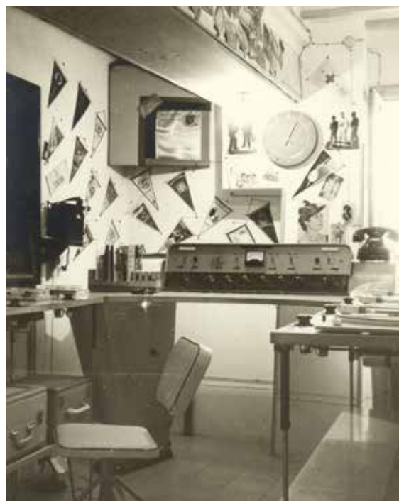
Lámina 5. Control de Radio Popular tras su instalación en la Corredera.
