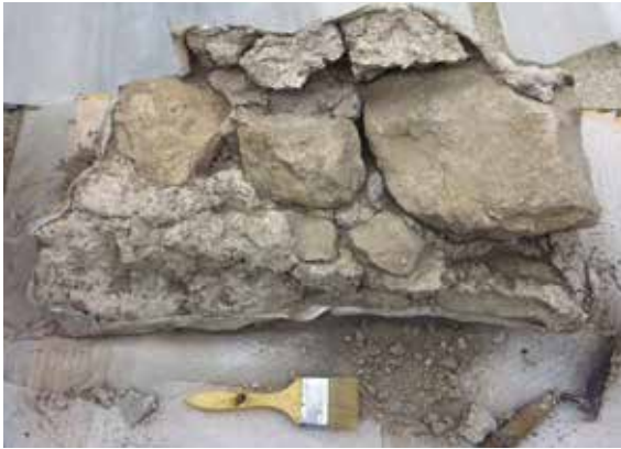
Lámina 6. Aligeramiento eliminando mampuestos.
