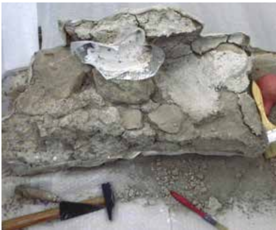
Lámina 8. Sustitución de mampuestos por escayola aligerada.
