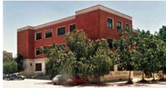
Lámina 7. Aspecto del IES Francisco Ros Giner en el año 1985. Vista de la fachada Este y puerta principal de acceso. Se aprecia el tipo de carpintería original y las persianas como mobiliario. (Fuente: Consejería de Educación).
