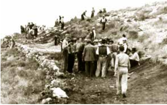
Lámina 8a. Vecinos arreglando el camino del cuartel de Percheles, sobre 1950.
