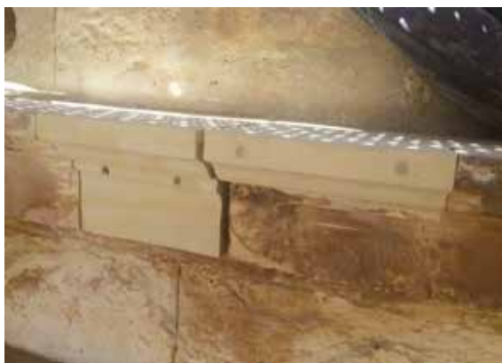
Lámina 13. Dos fotografías de los aleros del lateral sur de San patricio, sobre los que se ha procedido a colocar una plancha de plomo para asegurar su protección (arriba), así como a la ejecución de prótesis de piedra, en las zonas de máxima degradación o con falta de material (abajo).
