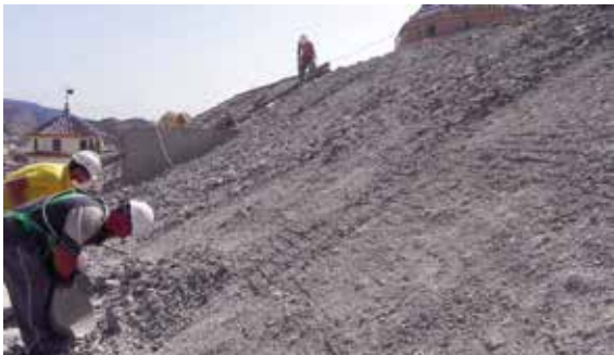
Lámina 1. Fotografía de la cubierta de la nave central de San Patricio, durante los trabajos de retirada de la losa de hormigón armada. Posteriormente se recuperó la ripia (donde estaba en buen estado), o se colocó un tablero contrachapado y, sobre ello, lámina de Onduline y la propia teja procedente del desmontaje, incluyendo los encuentros de plomo con todos los paramentos.
