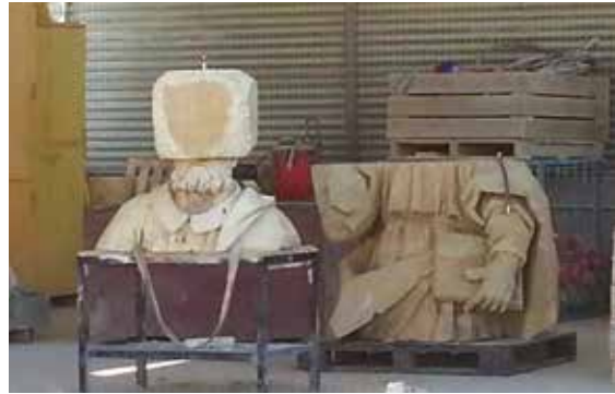
Lámina 6. Escultura sobre el primer piso del imafronte en el estado en mayo de 2011 (izquierda), en el taller de cantería con el nuevo sillar para su completamiento (centro) y en su estado final con la ejecución de los rasgos principales, sin introducir talla de detalle (derecha).
