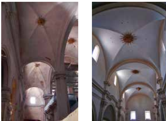
Lámina 4. Fotografías del estado previo (izquierda) y final, una vez reparadas las bóvedas, así como los pinjantes dorados, el yeso y las pátinas de los arcos, paramentos, etcétera (derecha) (Fotografía: Pablo Molina).
