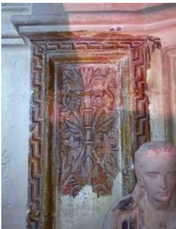
Lámina 16. Fotografías realizadas sobre las pilastras de la girola, una vez efectuadas las catas para descubrir pinturas subyacentes. En la superior se aprecian motivos y decoraciones de clara ejecución dentro de los cánones renacentistas, mientras que en la inferior se ven un detalle de las mismas, en la pilastra central que divide los dos arcos que comunican la girola con la capilla del Alcázar.
