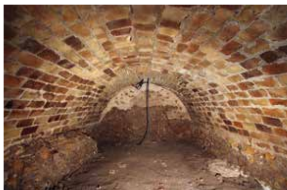
Lámina 8. Fotografías de la cripta de mayor tamaño de entre las encontradas en la colegiata, situada a los pies del templo, en la nave de la Epístola, apreciándose el trasdós (arriba) y desde el interior (abajo) (Fotografías: Carmen Martínez Ríos).
