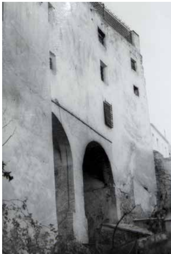
Lámina 12. Convento de Madre de Dios de Consolación, Lorca (Murcia). Patio. Fotografía de Pedro A. San Martín Moro, 1965. AGIPCE.
