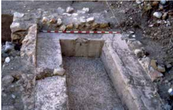
Lámina 17. Planta de la cripta de la primitiva iglesia del convento de Madre de Dios de Consolación, Lorca (Murcia).
