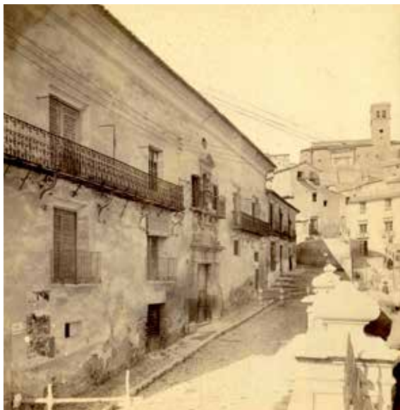
Lámina 3. Detalle de la fachada principal de la Casa del Corregidor en la que se puede ver además la cubrición de la iglesia de Santa María antes de ser destruida durante la guerra civil y su abandono posterior. Fotografía tomada hacia 1900. Fuente: FCE-CAM.
