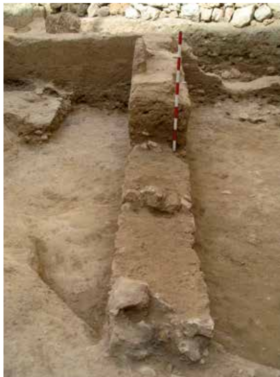
Lámina 4. Vista del sistema empleado para cimentar los muros de tapial.
