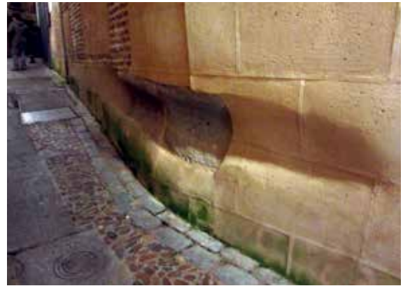
Lámina 6. Marca producida en el muro de una casa por el roce de carruajes en una estrecha calle de Toledo. Fotografía 2013: Andrés Martínez Rodríguez.
