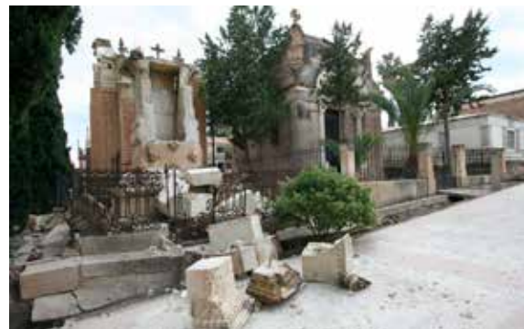
Lámina 18. Panteón familiar. Cementerio de San Clemente. Rotura de sillares de muro y remate por vuelco del cerramiento.
