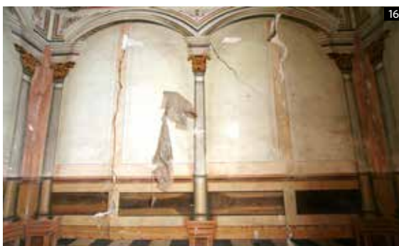
Lámina 14. Casa de don Pedro Arcas. Daños en la caja de escaleras, con el colapso de tramos abovedados y desprendimiento de revestimientos.
