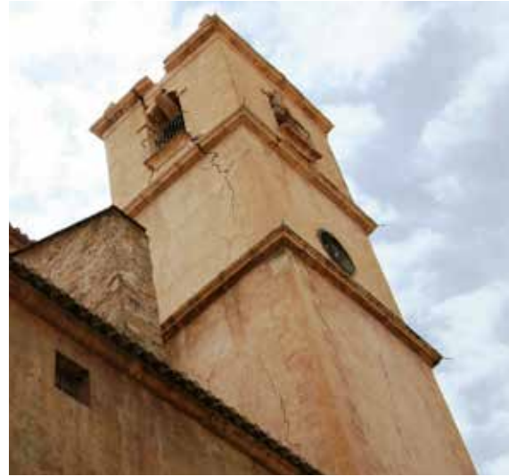
Lámina 8. Iglesia de San Francisco. Desplazamiento de las claves de los arcos de las fachadas de la torre orientadas en la dirección noroeste-sureste.
