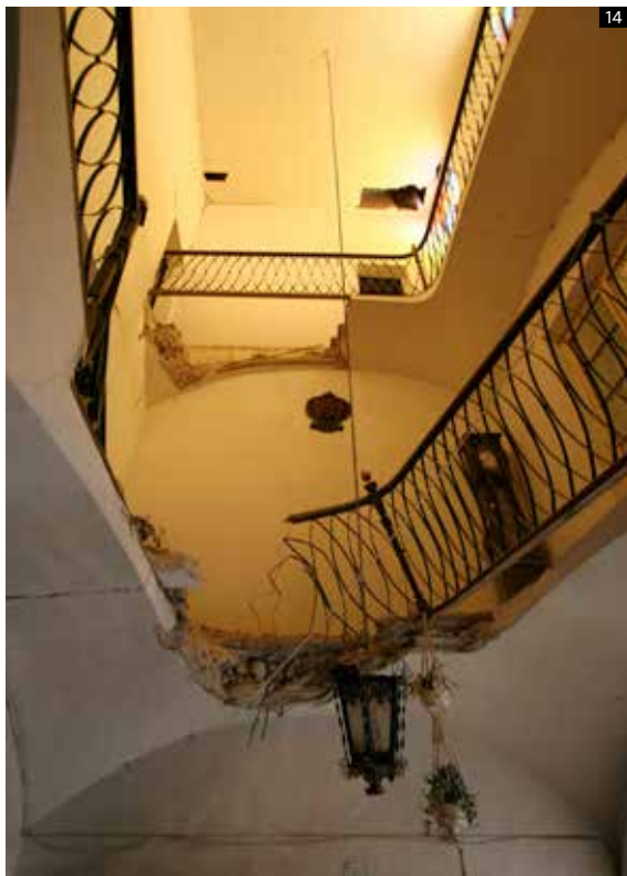
Lámina 14. Casa de don Pedro Arcas. Daños en la caja de escaleras, con el colapso de tramos abovedados y desprendimiento de revestimientos.
