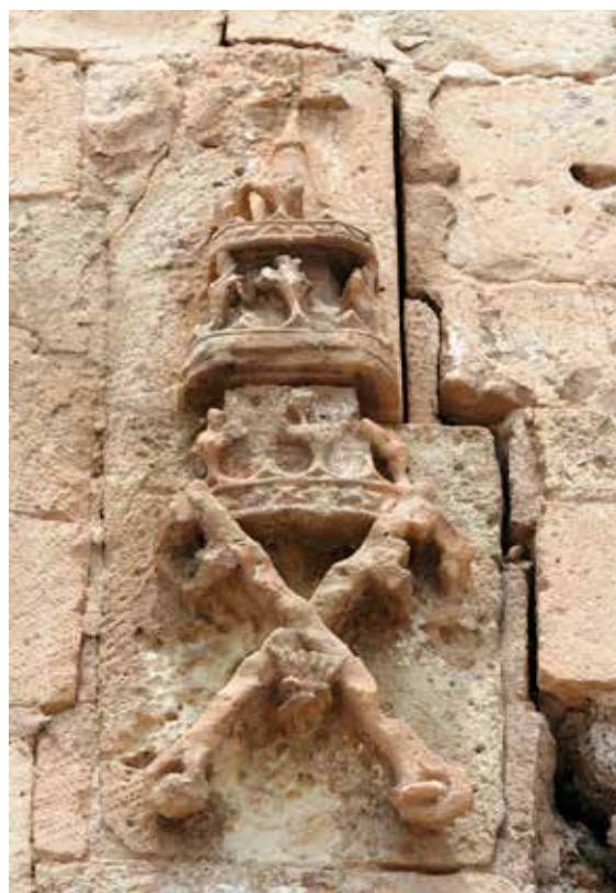
Lámina 3. Iglesia de San Pedro. Vuelco de la hoja exterior en sillería del muro de la fachada principal con juntas de sillares abiertas en el encuentro con la portada gótica.
