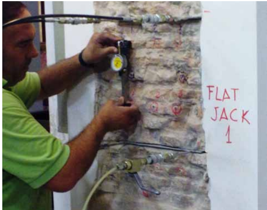
Lámina 5. Ensayos de doble gato plano para determinación de las características mecánicas de la fábrica.
