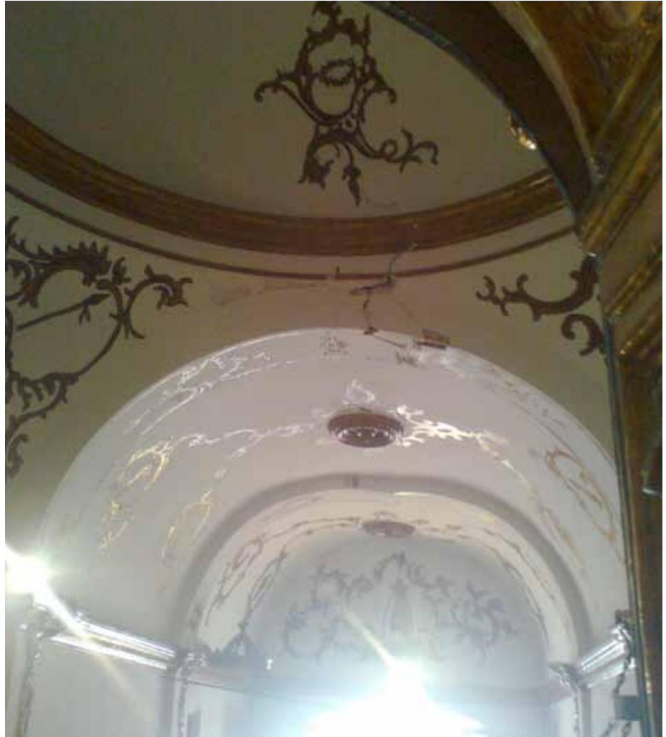
Lámina 4. Aspecto que presentaban los arcos fajones y la bóveda tras producirse rotura por la clave.
