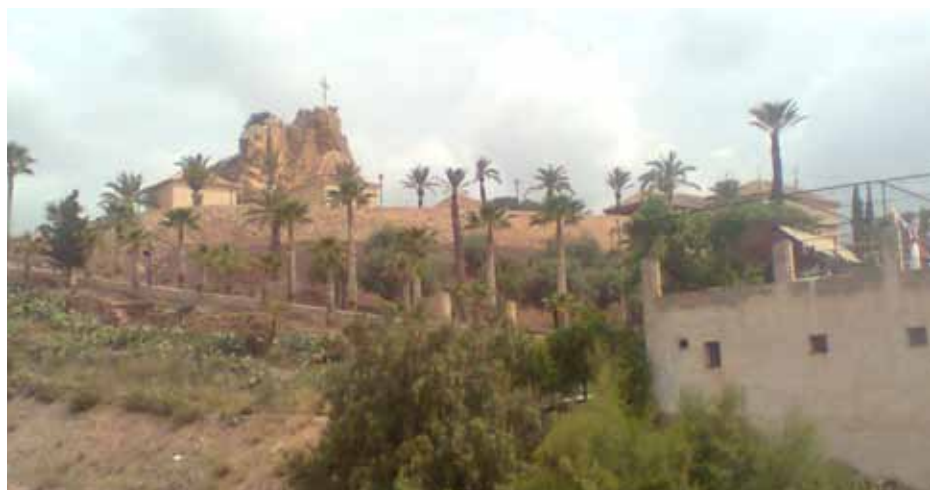
Lámina 1. Vista general del conjunto. Ermita del Calvario.
