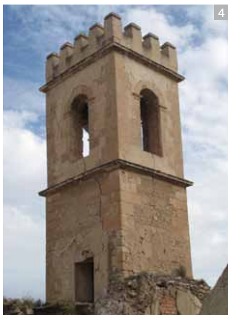
Lámina 5. Imagen del acceso con grietas sobre el arco de entrada. Fotografías realizadas el 17 de mayo de 2011.
