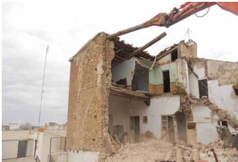
Lámina 1. Torreón 12, mayo 2011. Obras de emergencia de demolición de la edificación situada sobre el torreón.
