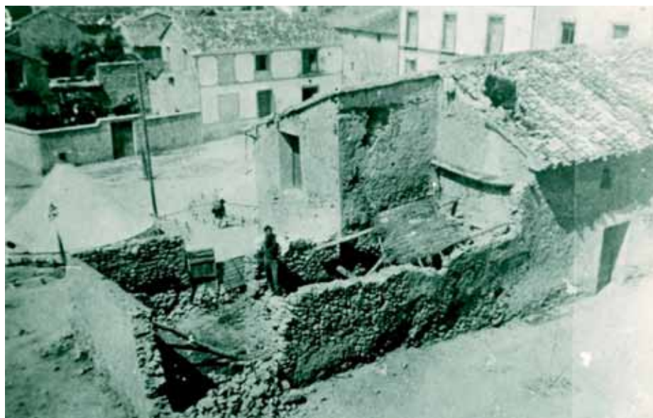
Lámina 1. Vivienda dañada terremoto de Lorquí 1911. Foto Ayuntamiento de Lorquí en Atlas Global de la Región de Murcia .
